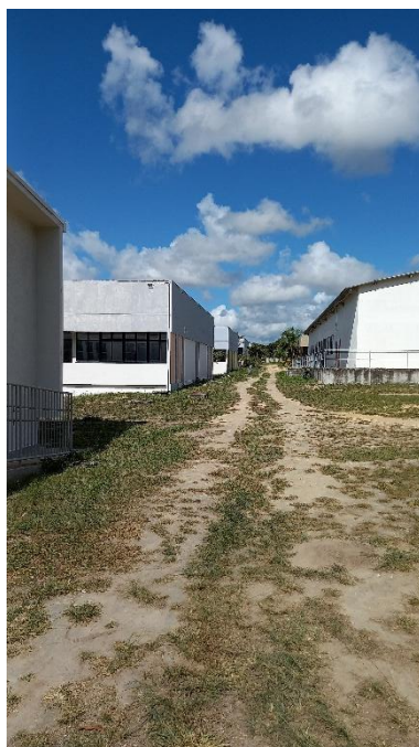
Acesso prejudicado aos prédios do Eixo 4
