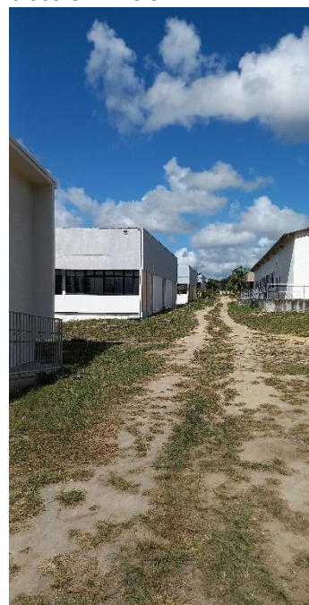
Acesso ao Eixo 4 com dificuldade e sem acessibilidade.
