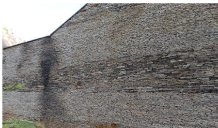
Parede externa elaborada com pedras
