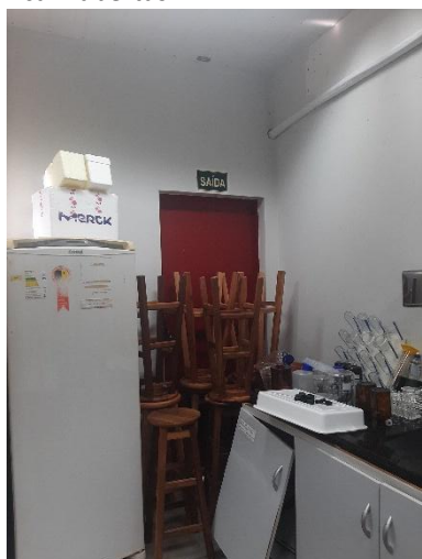
Saída de emergência obstruída
