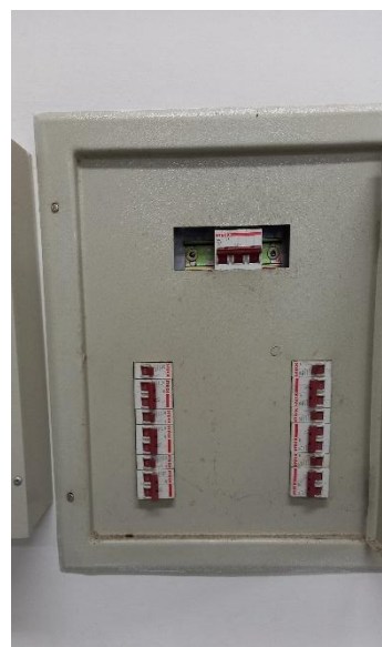
Lab. 09 (Microscopia) - Disjuntores sem identificação
