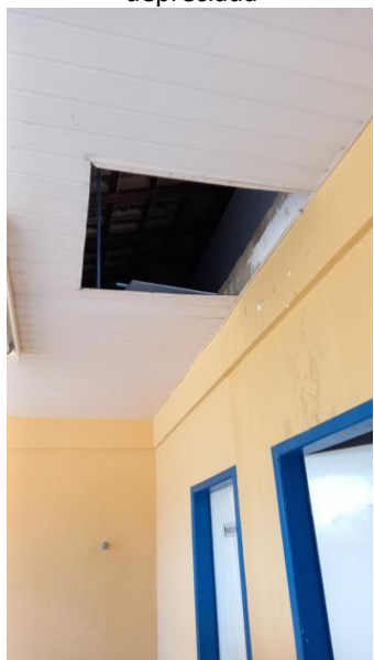
Forro aberto prédio da madeira
