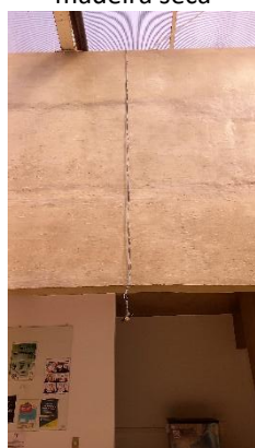
Fio de tomada improvisado no meio do pátio
