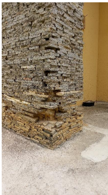
Parede externa elaborada com pedras
