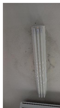
Sinais de infiltração próximo ao ponto de energia
