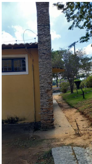
Parede externa elaborada com pedras
